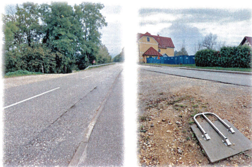
Sliki 8 in 9: Regionalna cesta pri Metelkovem domu
